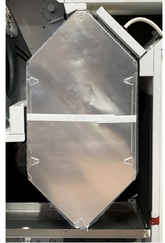
Värmeväxlarkassett
